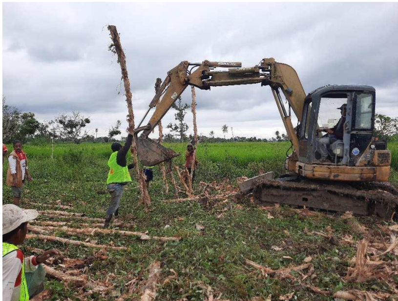
Gambar 4. Pemancangan pondasi kayu gelam
