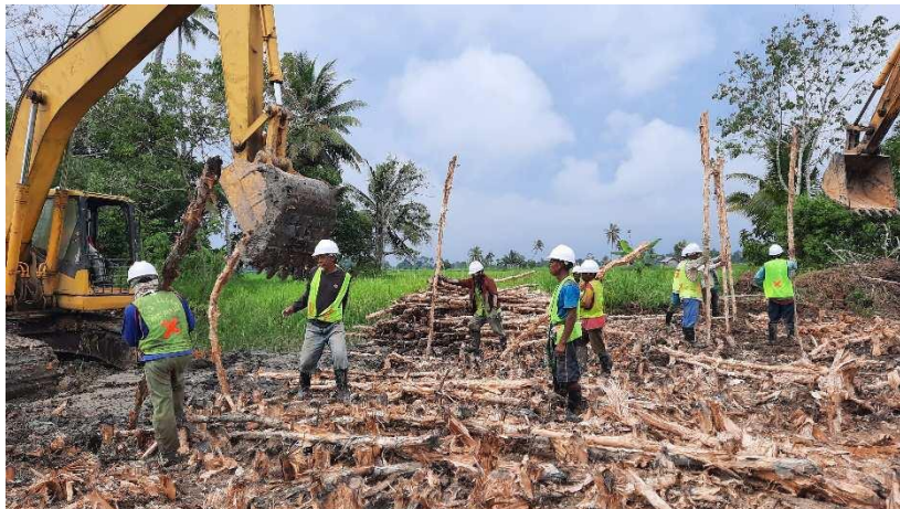
Gambar 4. Kayu gelam dalam pekerjaan jalan
