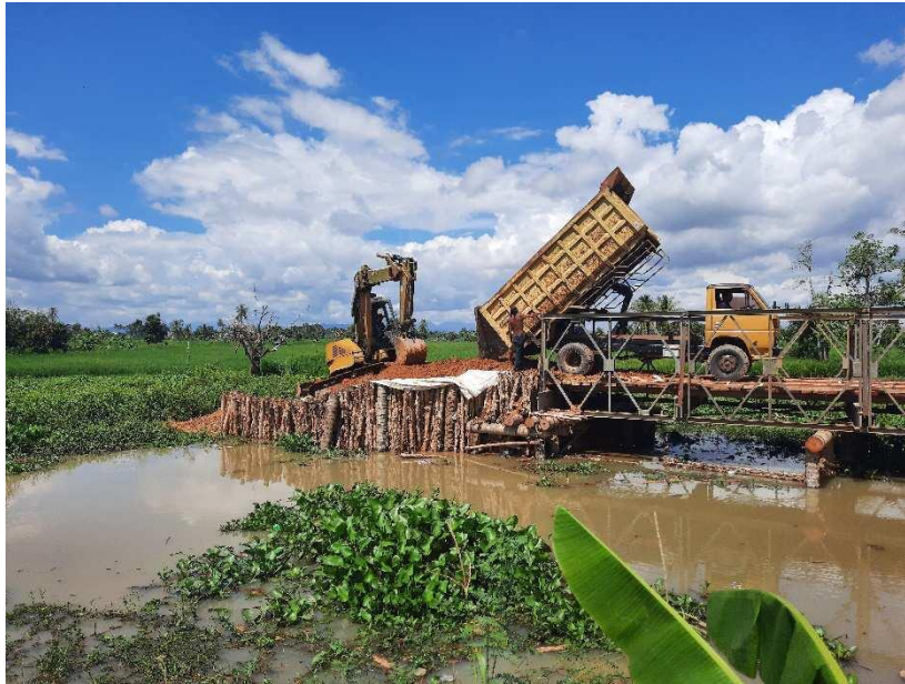
Gambar 5. Dinding kayu gelam pada oprit jembatan
