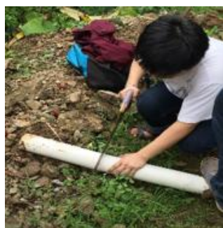
Gambar 4. Pemotongan Pipa PVC
