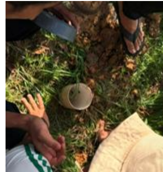
Gambar 7. Pemasangan Pipa Biopori
