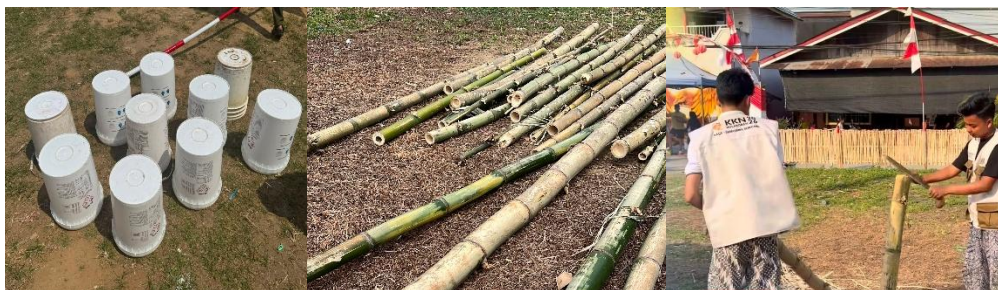
Gambar 4. Proses persiapan, pengukuran, dan pemotongan bambu sebagai bahan kerangka tong sampah.
