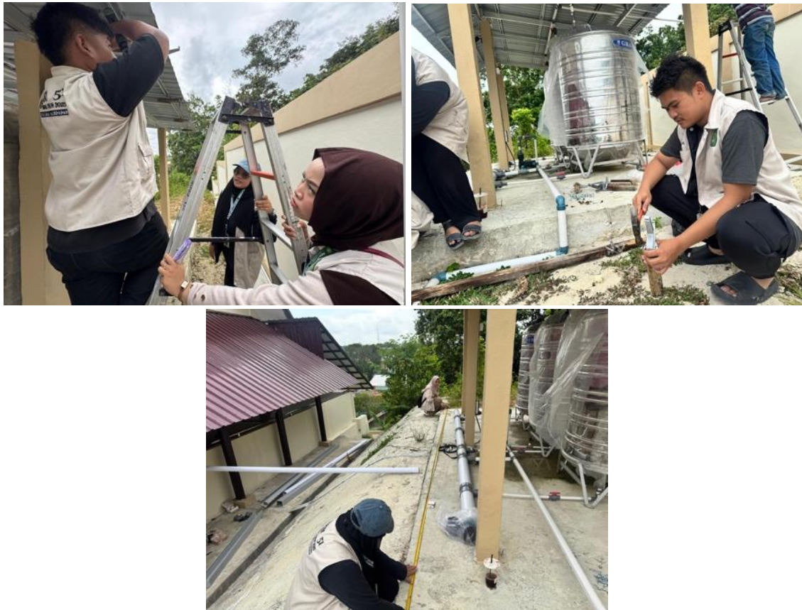
Gambar 3. Proses instalasi IPAH di halaman Kelurahan Sepinggan Baru
