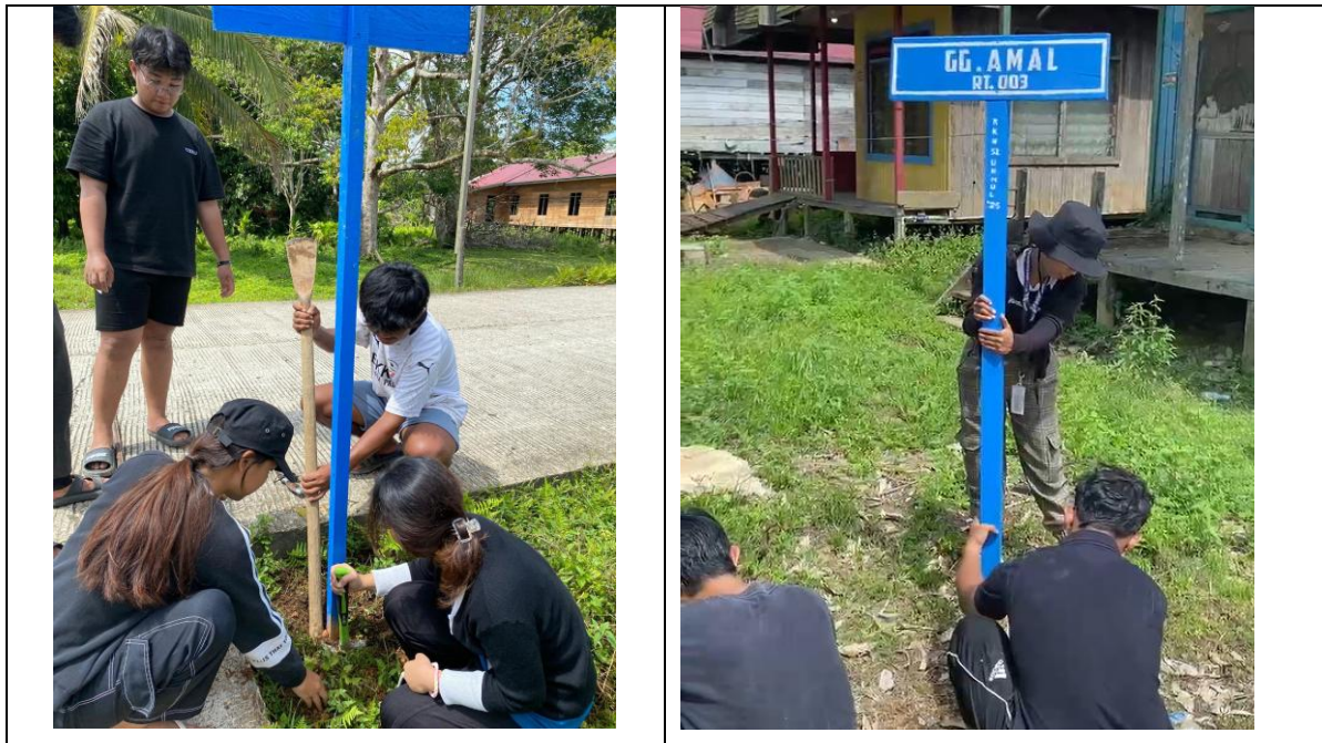
Gambar 3. Proses Pemasangan Pajalis dengan Menggunakan Linggis dan Sekop Datar untuk Dapat Menggali dan Menanam Pajalis ke dalam Tanah
