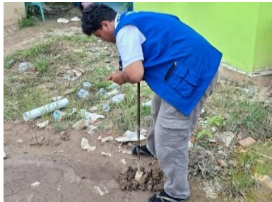
Gambar 4. Proses Pemasangan Biopori
