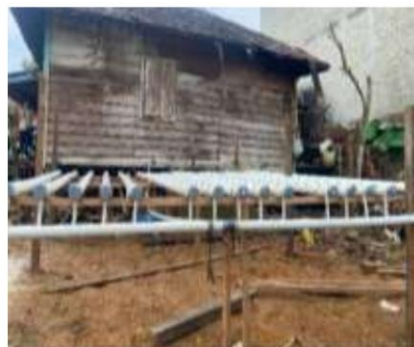
Gambar 5. Instalasi hidroponik selesai
