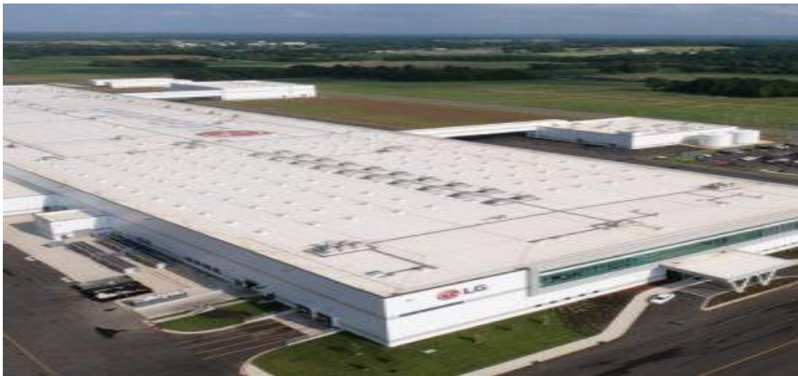
Gambar 5. Pabrik sel Baterai EV Indonesia
