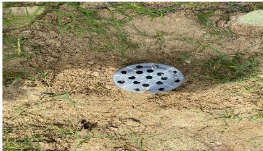
Gambar 5. Penanaman akhir ke lubang biopori
