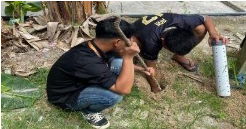
Gambar 2. Tahap penggalian tanah dalam pembuatan lubang resapan biopori
