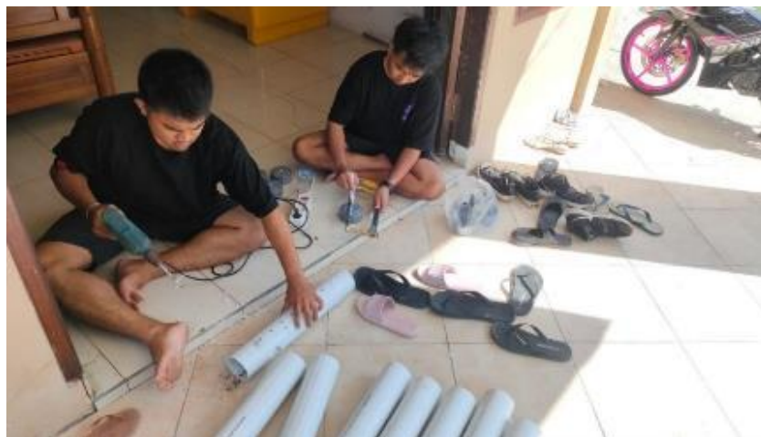
Gambar 1. Melakukan persiapan bahan pipa biopori.
