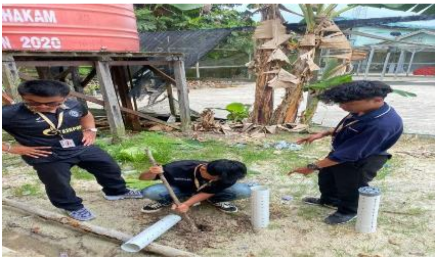
Gambar 3. Proses memasukkan pipa ke dalam tanah
