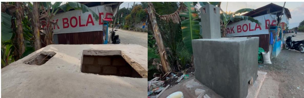
Gambar 3. Pembangunan cerobong asap dan finishing
