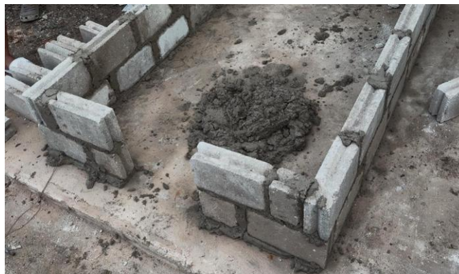
Gambar 1. Pembangunan Pondasi dari pembakaran Rocket Stove
