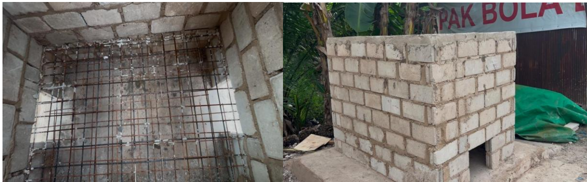
Gambar 2. Pembentukan ruang bakar Rocket Stove
