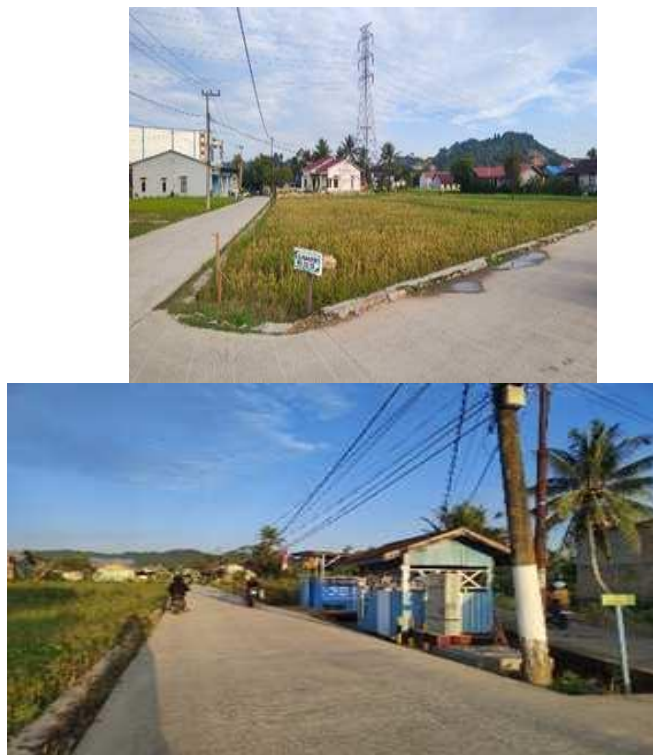
Gambar 12. Foto Eksisting Kondisi Jalan
