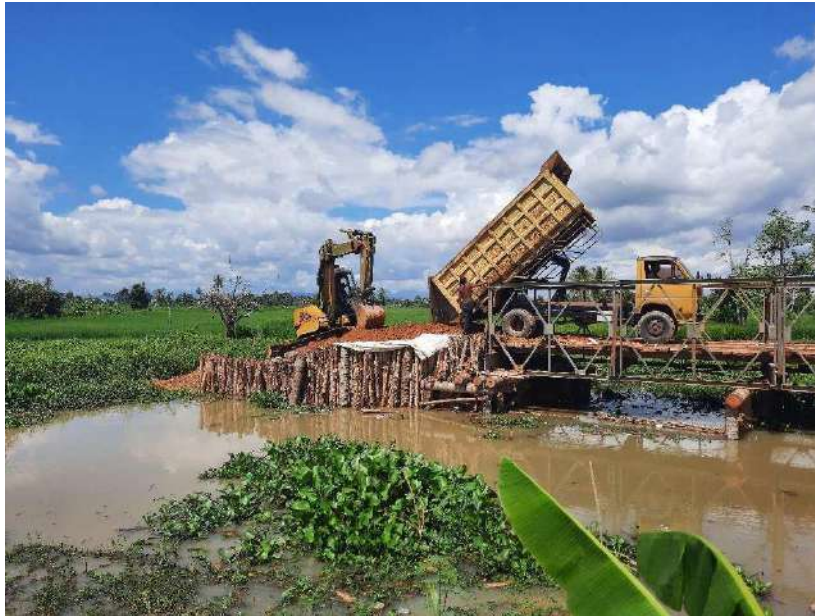
Gambar 5. Dinding kayu gelam pada oprit jembatan
