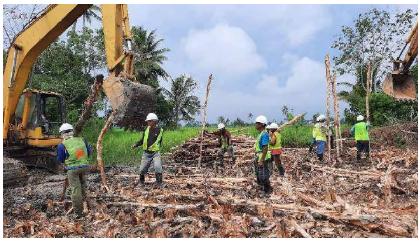
Gambar 4. Kayu gelam dalam pekerjaan jalan
