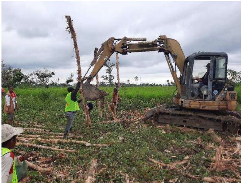
Gambar 4. Pemancangan pondasi kayu gelam
