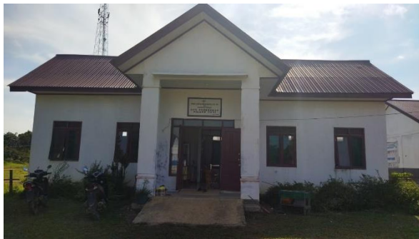
Gambar 2.5. Ruang UGD dan Rawat Inap
