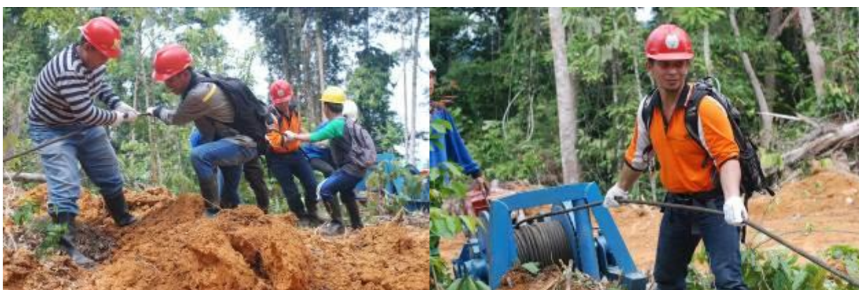
Gambar 6. Praktek penarikan kabel sling ke bontos log.
